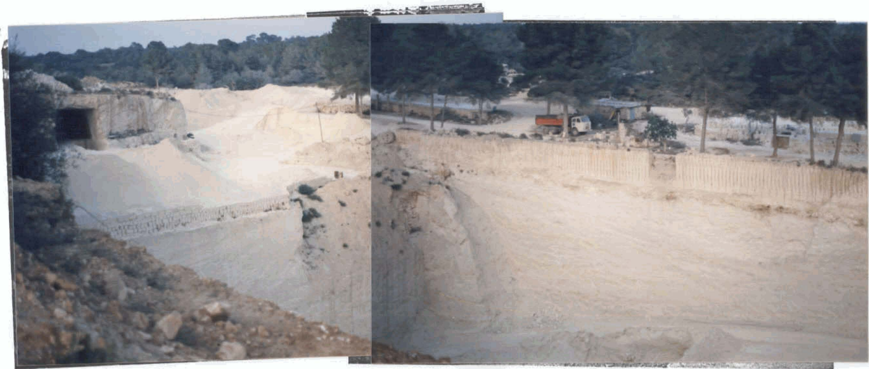
FOTO Nº 5.2. - CANTERA CAN CASITAS (PALMA DE MALLORCA)
